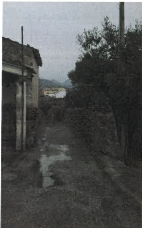
Foto 4: Calle Son Sant Joan – entrada solar nº12. Postensa de acometida eléctrica del solar nº12 que se sitúa en la alineación correcta según planeamiento vigente, por detrás del marge. Esta postensa es el punto de conexión otorgado por ENDESA para el suministro eléctrico del solar nº14
